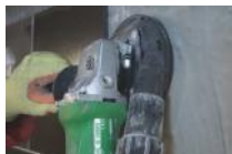
staubfreies Schleifen von Fliesenkleber
