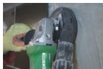
staubfreies Schleifen von Fliesenkleber
